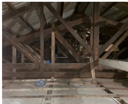
Troca das telhas em toda extensão do templo: nave principal e anexos (mezanino).
