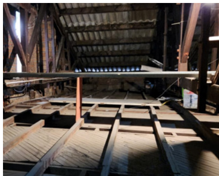
Troca das estruturas em madeira e alvenaria que dão suporte ao telhado.
